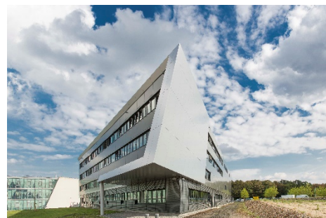
Außenansicht der Open Hybrid LabFactory. Bildnachweis: NFF/Bierwagen
